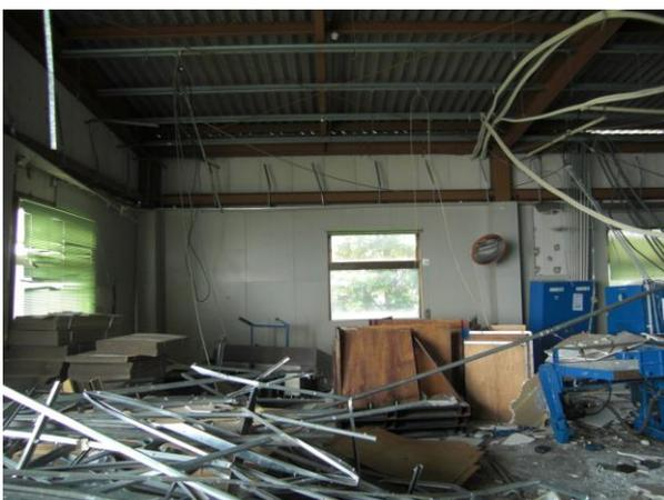
左の写真は地震がひどかった西原村の工場で、折版屋根にはペフの結露防止の断熱のみで、天井はほぼ落ちてしまい、天井埋め込みのカセットエアコンもかろうじて2本のボルトと配管で支えられ落下は免れたものの今後運転はできません。
