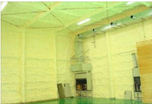
商品のための倉庫は原則人の出入りが少なく、作業する時間も限られているため、商品を傷めないことが第一優先です、そこで米や生鮮食品を保管する倉庫は基本15℃の定温にする必要があります、窓などの開口を最小限にして、壁から屋根までアイシネンなどの高気密高断熱で空調のエネルギー消費を最小限にする必要があります、何より結露を発生させないことが一番重要、しっかりした計画と施工が重要です。
